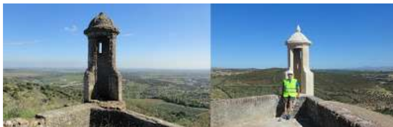
Garita del Forte da Graça, antes y después de la rehabilitación
